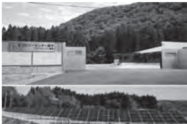
エコロジーセンター愛子の外観（上） 同施設太陽光パネル（下）
