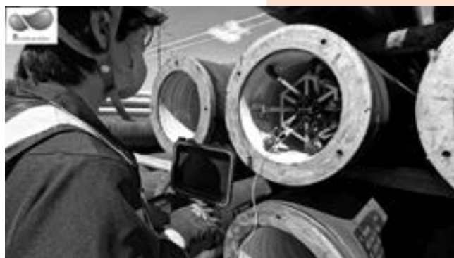
PC杭内面撮影ロボットを使用している様子
